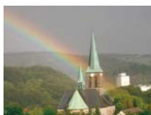
Kirche St. Mariä Geburt in Dilldorf Dilldorfer Str. 34 45257 Essen
